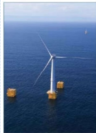
V字型セミサブ浮体 (7MW) 平成27年12月運転開始
