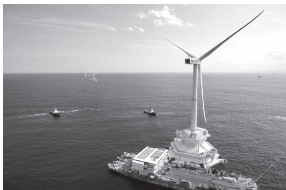
写真1 実証事業全景
