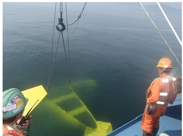
写真-1 アンカー降下
