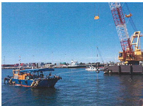
写真-11 フィルターユニット設置作業
