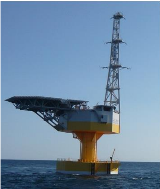
写真-8 稼働中の SS 全景
