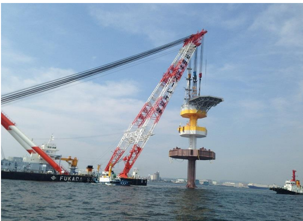
写真-3 起重機船による吊り出し
