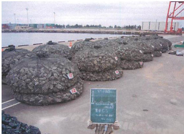
写真-10 着底用フィルターユニット
