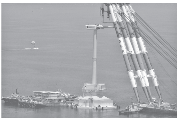
図9 風車搭載作業
