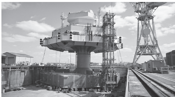
図7 工場内での浮体組立
