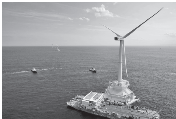
図11 現地海域に到着した「ふくしま浜風」(ウィンドファーム内の全風車と変電所が写っているため、一部でかなり有名になった写真)
