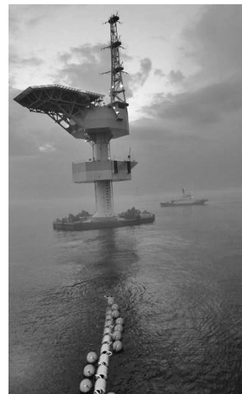
図 7 サブステーションへのライザーケーブル布設
