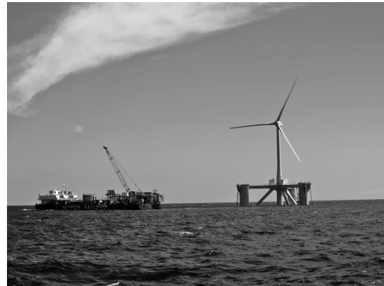
図 12 2MW 風車浮体へのライザーケーブル布設
