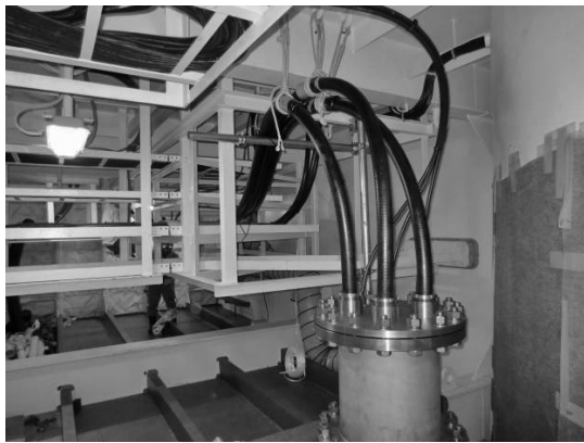
図 8 浮体内でのライザーケーブル固定状況
