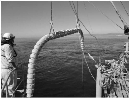
図 9 海底ジョイント沈設作業
