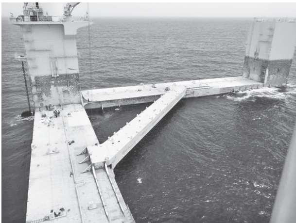
図12 恒久対策工事完了後
