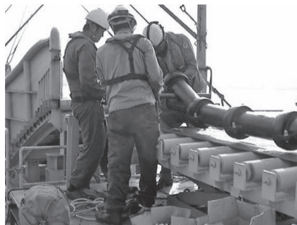
写真-10 ケーブル敷設時における防護管の取り付け状況
