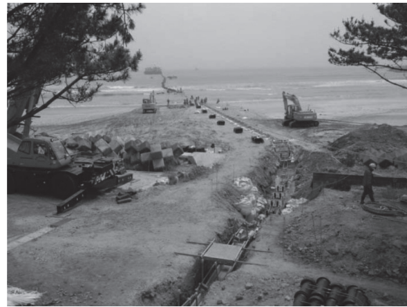
写真-9 海底ケーブルの陸揚げ状況
