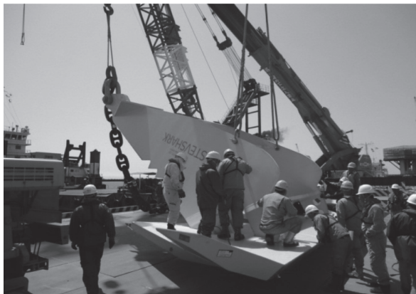
写真-2 係留アンカー組立状況
