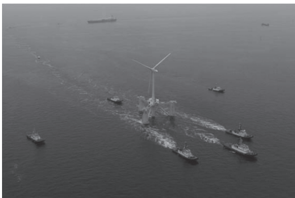
写真一6 2MW級洋上風力発電船の曳航状況
