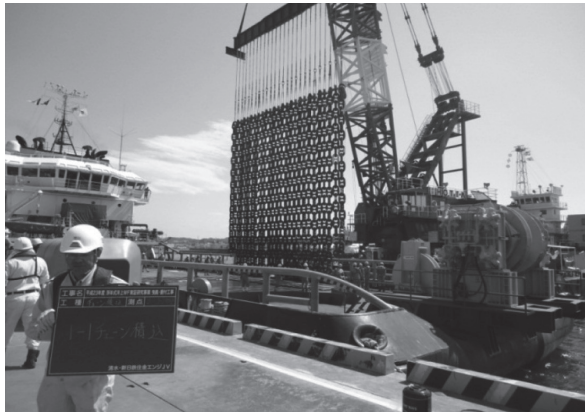
写真-1 500t吊クレーン台船による敷設船への係留チェーン積込状況
