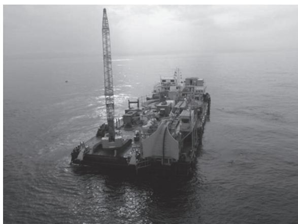
写真-11 敷設台船からのライザーケーブル送出しの状況
