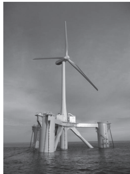
写真一8 設置完了後の2MW級洋上風力発電船の状況
