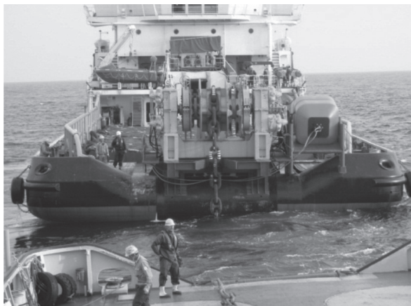
写真-3 係留アンカー・チェーン設置状況
