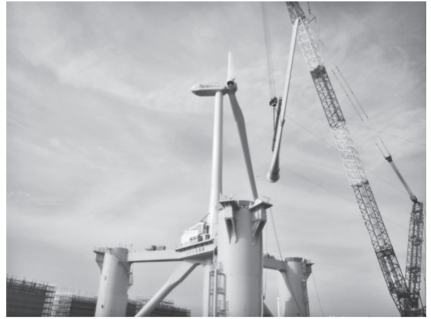
図3 風車の組立て
