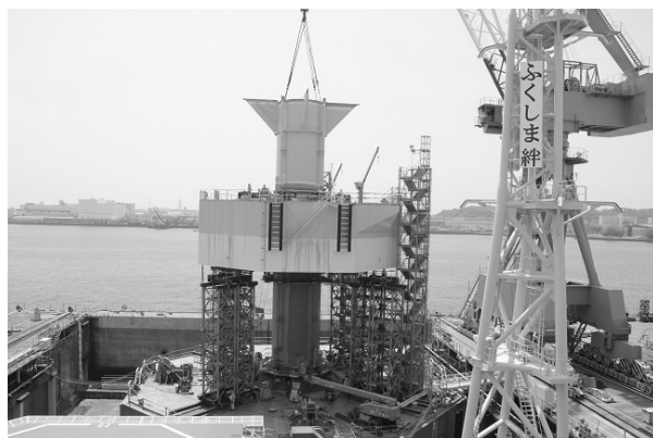
図11 ミドルハルとCOBハルの結合
