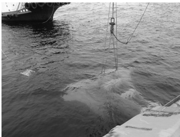
図14 アンカー降下
