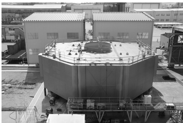
図9 COBハルの組み立て
