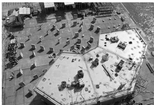
図10 ローハルの組み立て
