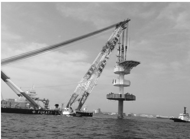
図19 起重機船による吊り出し
