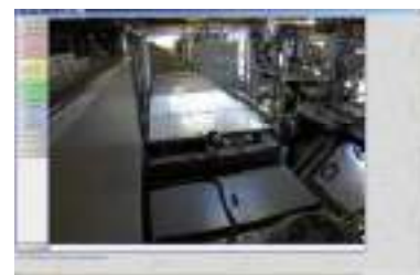
カメラによる遠隔からのナセル内確認
