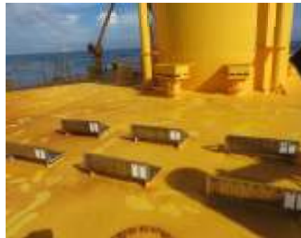
サブステーション上の曝露試験片
