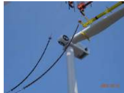
起重機船を用いた、洋上でのハブへのブレードの取付け
