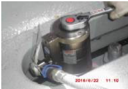
翼ボルトの増し締め
