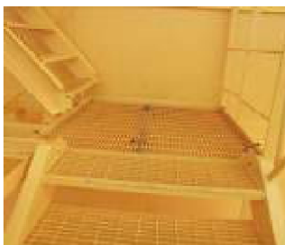
5MW浮体 台風被害補修後の階段踊り場
