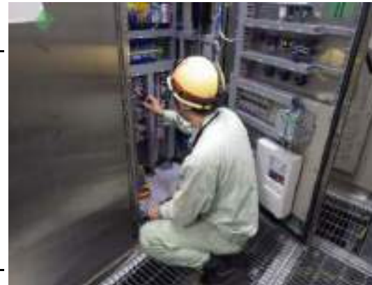
風車制御盤でI/Oチェックの様子 (2017年1月初旬)
