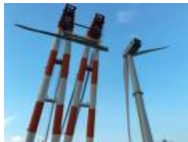
ブレード据付風景 (2016年5月下旬)
