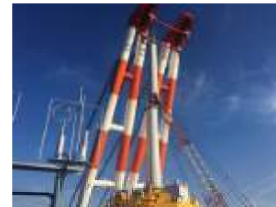
タワー据付風景 (2016年5月中旬)
