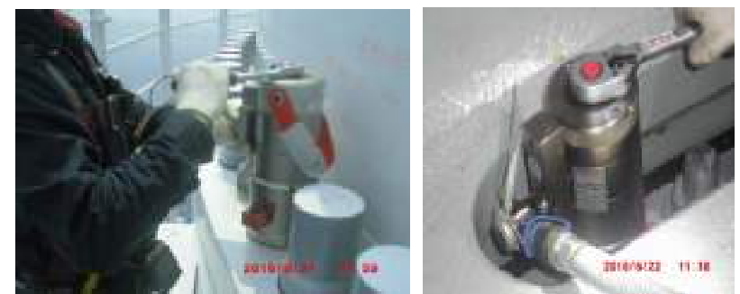
タワーボルト及び翼ボルトの増し締め
