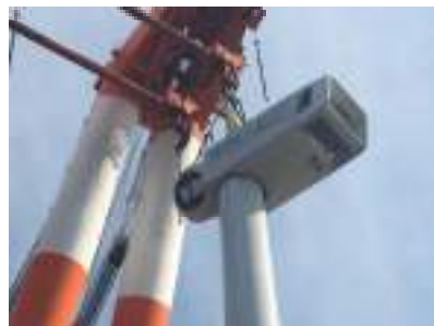
ナセル据付風景 (2016年5月中旬)
