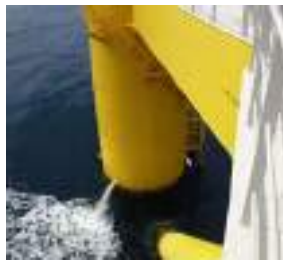
バラスタタンク内検査のための排水作業
