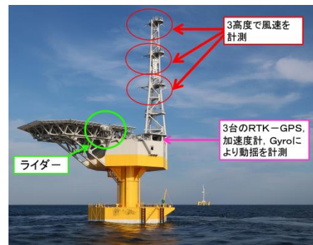
図1 福島洋上サブステーション
