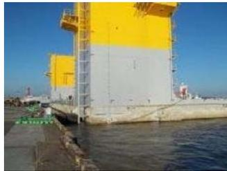
小名浜港へ入港後藤原埠頭先端へ引き寄せ位置調整／バラスト注水し着底
