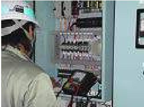
電気系統の絶縁抵抗計測の様子
