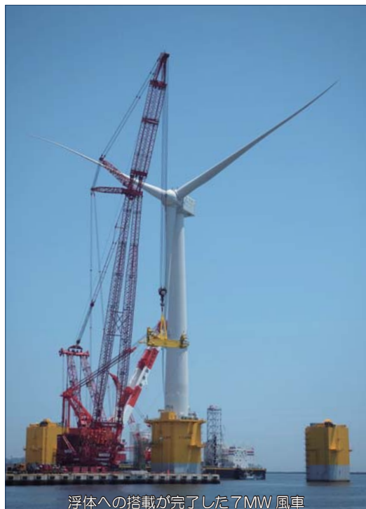
浮体への搭載が完了した7MW 風車
