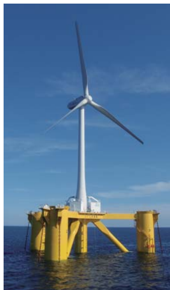
2MWダウンウィンド型浮体式洋上風力発電設備「ふくしま未来」
