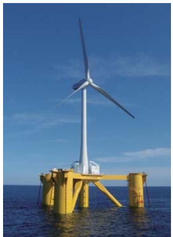
2MWダウンウィンド型浮体式洋上風力発電設備「ふくしま未来」
