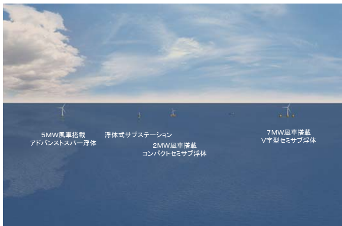
福島復興浮体式洋上ウィンドファーム実証研究事業設備全景
