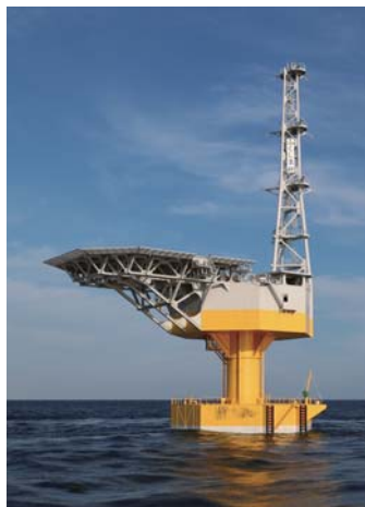
浮体式洋上サブステーション「ふくしま絆」
